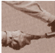
3. ทำความสะอาดภายในท่อ
