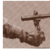
2. ตัดโดยใช้คัตเตอร์ตัดท่อ
